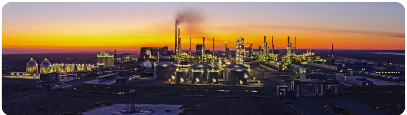
吉木乃LNG工厂：150万Nm<sup>3</sup>/d液化天然气项目气源来自境外收购的哈萨克斯坦斋桑油气田，通过跨境天然气管道上下联动供应，利用天然气经深冷处理后生产出LNG产品。
